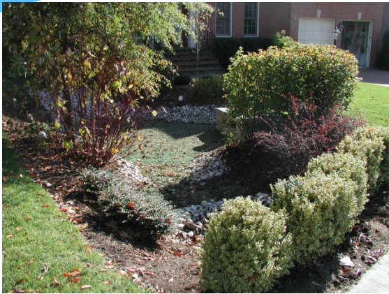
Kings Cloister Bioretention
