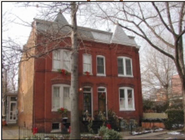
400 BLOCK N. WEST STREET
