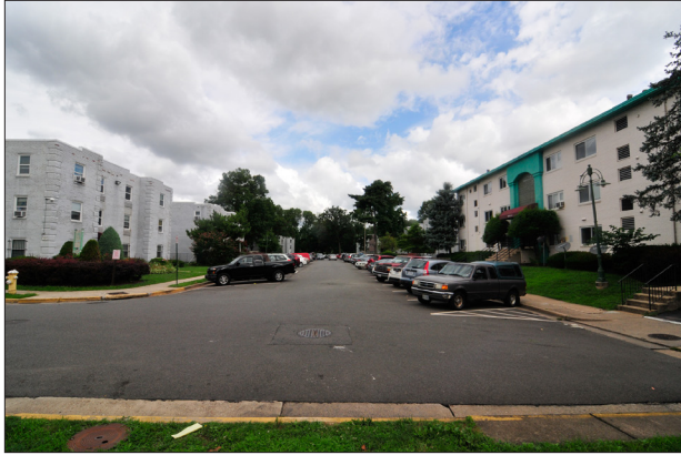
ACHC (Beverley Plaza Gardens), Bruce St, View North.jpg
